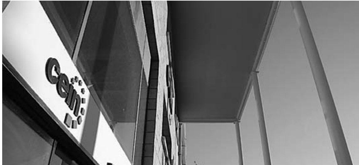
Fachada de las instalaciones de Cein, en el polígono industrial Mocholí, en Noáin. ARCHIVO
